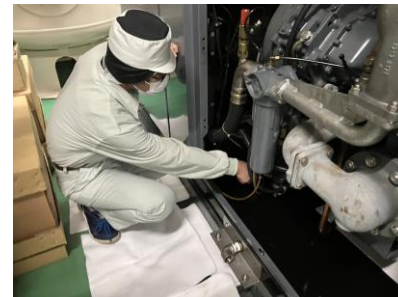
オイル漏洩緊急対応訓練(川北) (R5.9)
